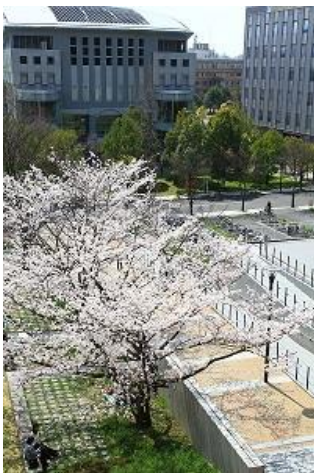
コンベンションセンター
